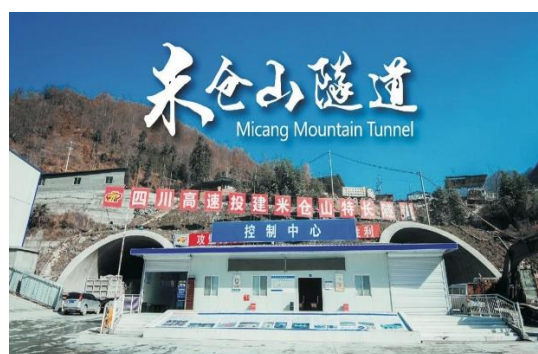
建设期间的米仓山隧道
